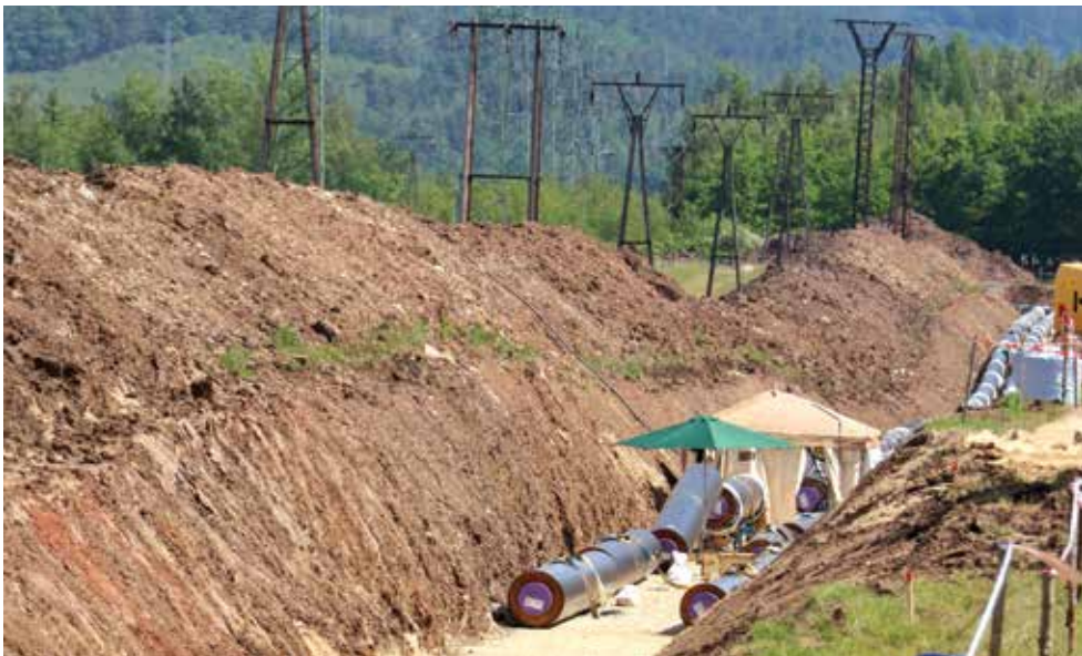
Práce na výstavbě nového horkovodu pokračují výkopy a pokládkou potrubí v první fázi. Foto M. Šil
