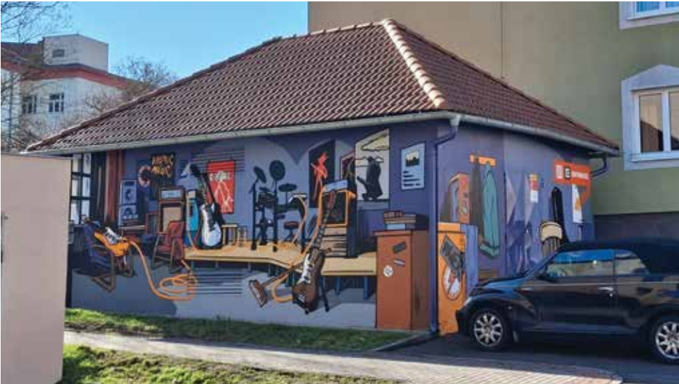
Výměník ve Dvořákové ulici. Foto M. Šil
