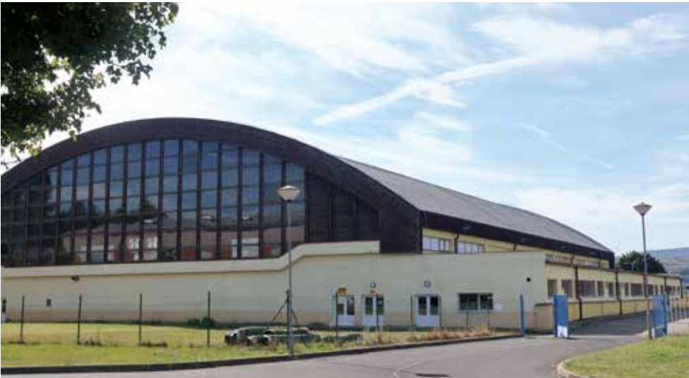
Na zimním stadionu byla vyměněna okna a instalována fotovoltaika. Foto M. Šil
