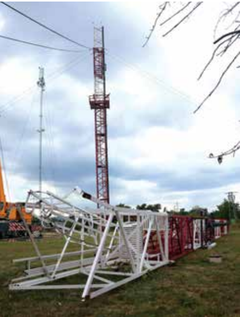
Likvidace probíhala 21. 22.8. za pomoci jeřábu, kdy byl stožár rozdělen na tři kusy, které se postupně pokládaly na zem. Foto M. Šil
