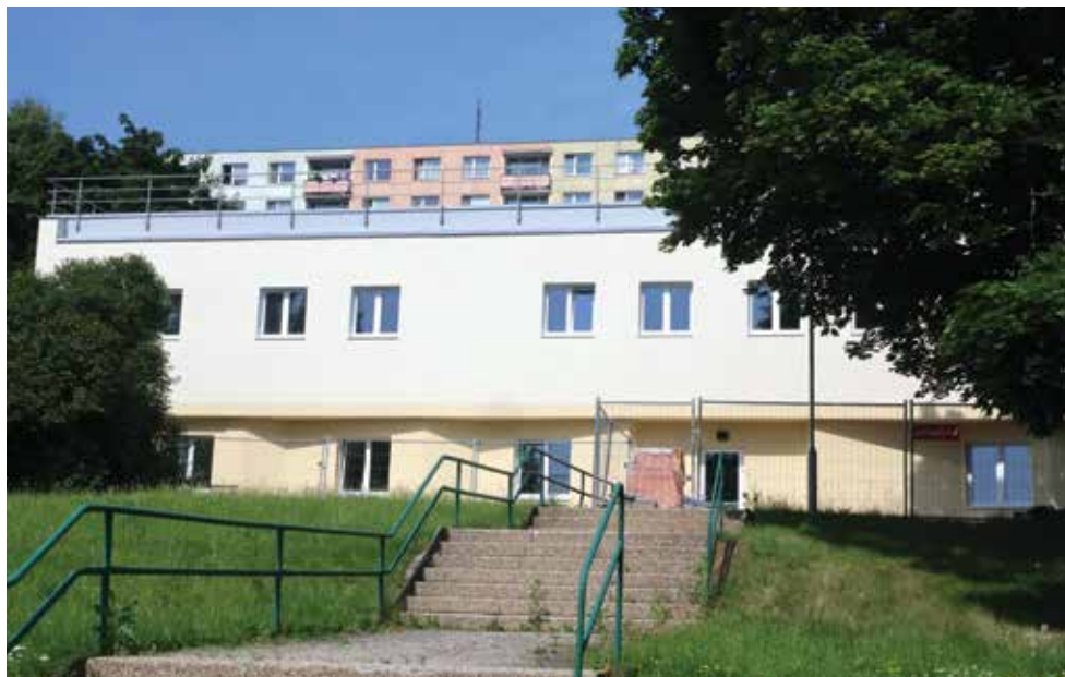
Interiér budoucího Domu se zvláštním režimem je již v podstatě dokončený a čeká na kolaudaci. Venkovní prostory se teprve budou upravovat. Foto M. Šil
